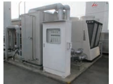
①真空ドラムドライヤー（VDD）チラー
