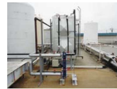
菓子工場屋上に温水タンク、送水ポンプ、熱交換器を設置。排蒸気回収タンクは既設の設備を改造し使用しました。
