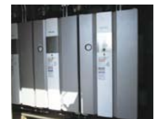
ボイラーの設置
